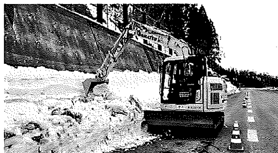
図-5 ICTバックホウ作業状況
