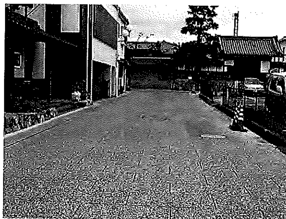
写真1 石畳風の半たわみ性舗装
