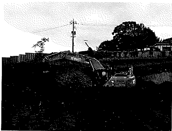
ICT重機による土工
