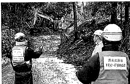
写真5－建設業団体等と連携した道路の緊急復旧 (石川県輪島市)
