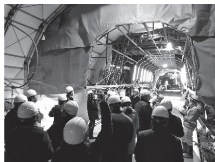
（仮称）北沢トンネル本体工事の現場視察会
