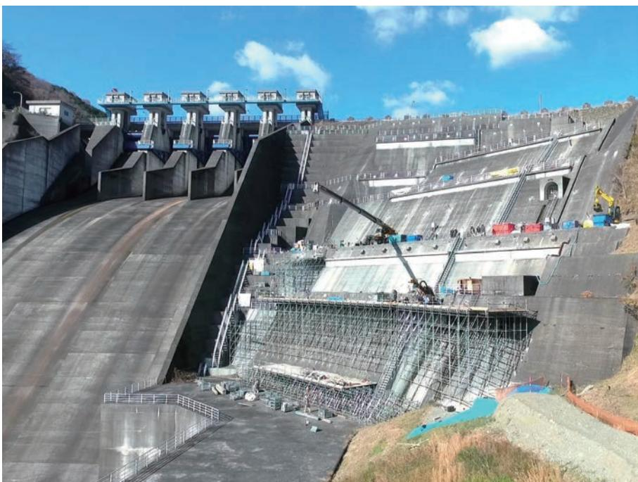
神奈川県の水源の一つ三保ダム、完成から40年経過し5門のゲート（水門）の右岸半島部のグラウンドアンカーの緊張力が腐食等により低下していることから、アンカーの更新工事。作業足場の設置が完了し、水門と足場がまるで要塞みたい。
