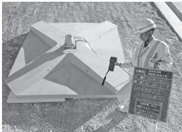
図-9 アンカー荷重計設置
