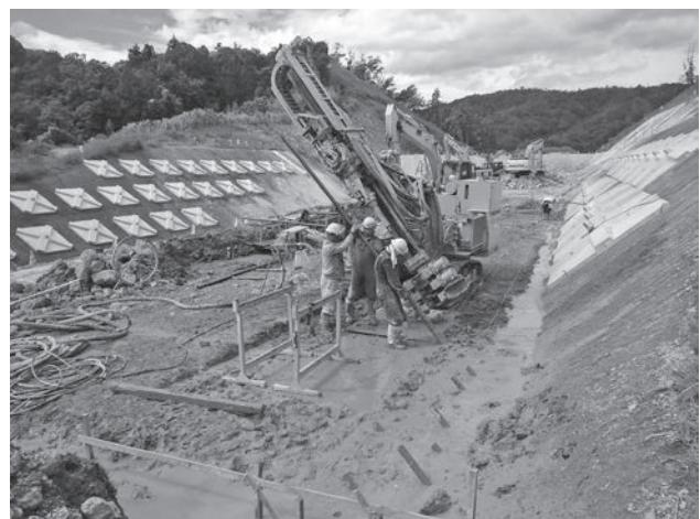
図-8 掘削用仮設対策工（スリット钢管）
