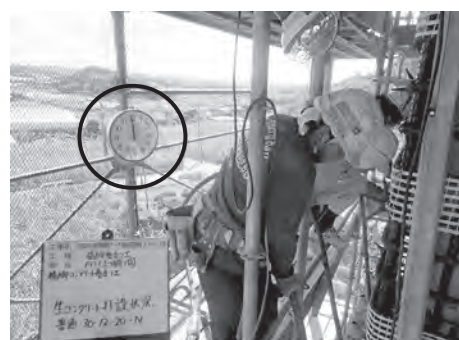
図-10 コンクリート打設締固め状況
