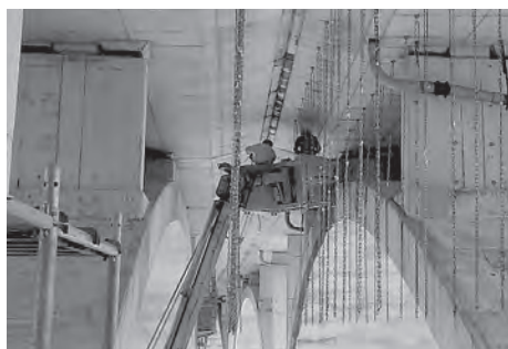
図-5 高所作業状況
