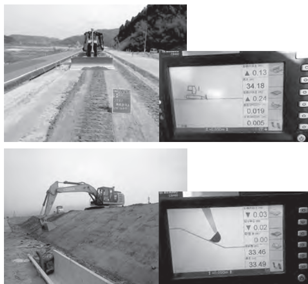
図-5 ICT建機による作業状況
