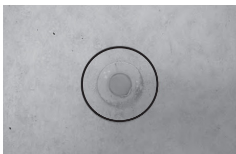
図-9 プロテックPコン施工
