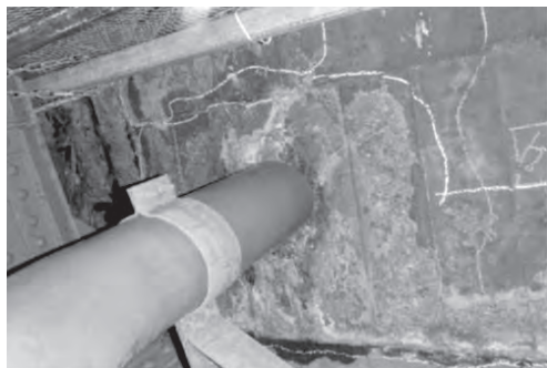
図-1 排水柵部漏水による損傷事例
