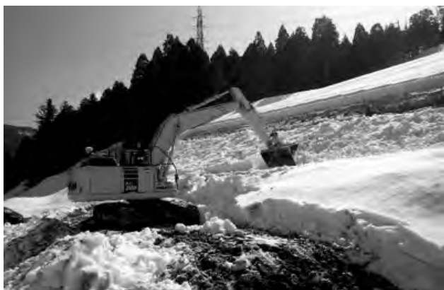
図-6 ICT建設機械での除雪作業
