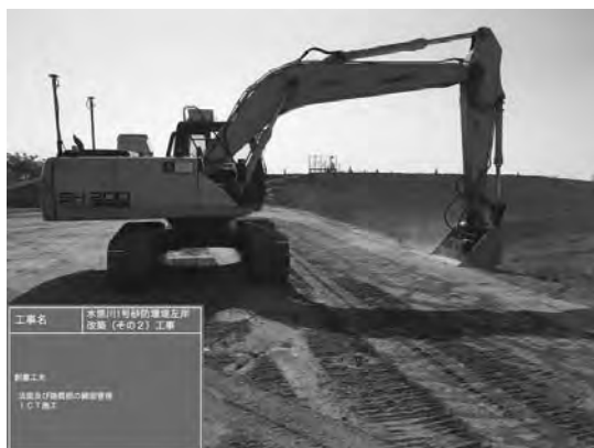
図-8 盛土端部の施工状況
