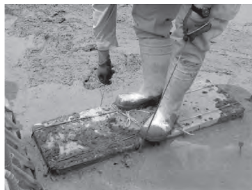
図-5 実工事における作業状況
