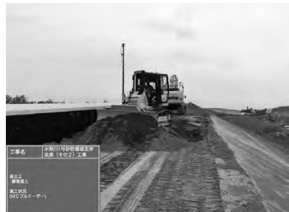
図-4 緩衝盛土ICT施工状況
