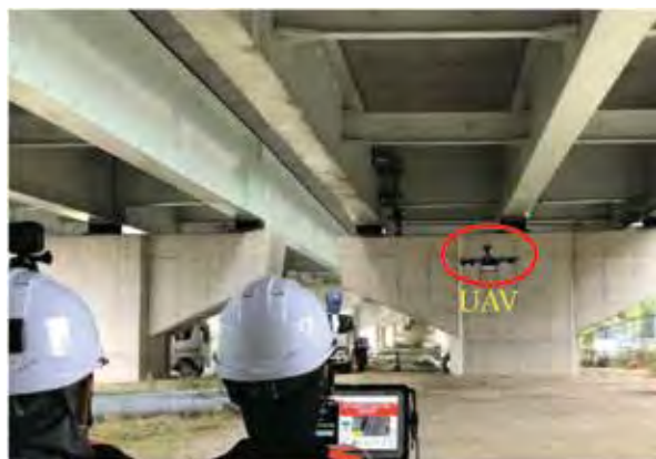
写真-3 UAV による点検状況
