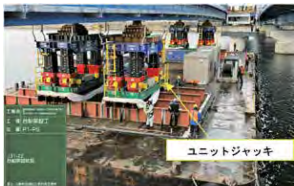
写真－７ ユニットジャッキ配置状況
