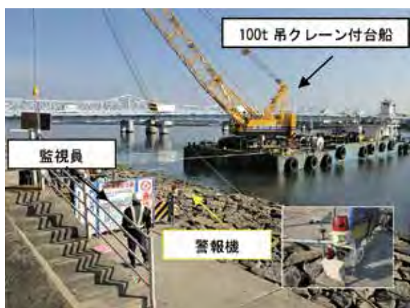
写真-5 監視員配置状況
