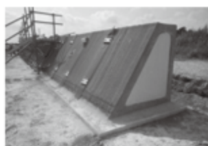
据付完了(L=5m)
