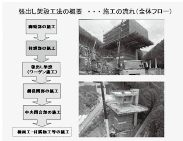
柱頭部の施工
