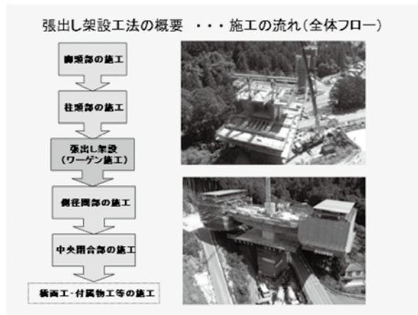
張出架設（ワーゲン施工）
