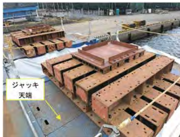
写真－８ ジャッキ天端上主桁受架台設備
