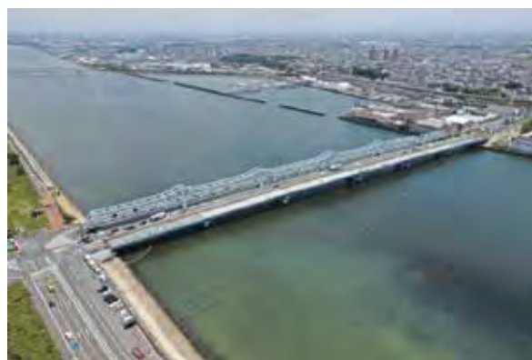
写真-14 竣工写真
