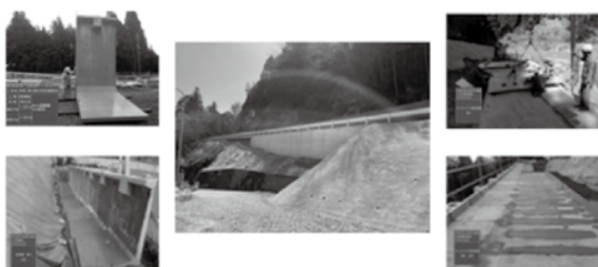
川向工区 L型擁壁+強出車道に変更
