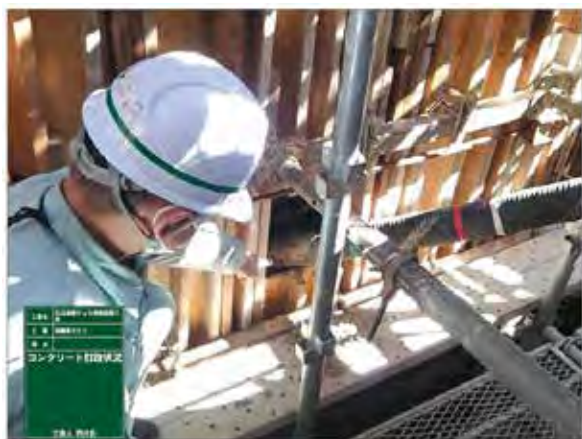
< 開口部より打設 >
