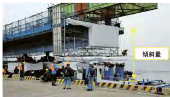
写真-2 傾斜量計測状況
