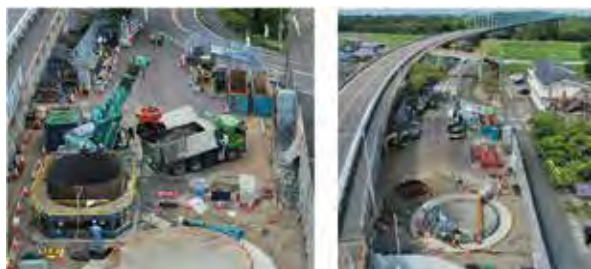
図. 8 管理坑の圧入状況（右）と完了（左）
