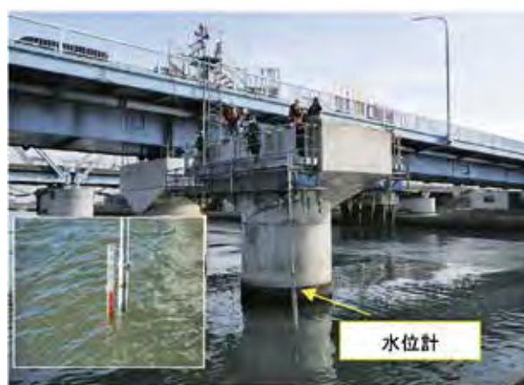
写真-6 水位計設置状況
