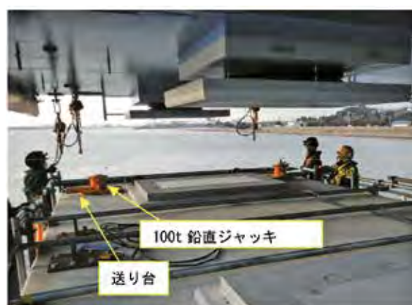
写真-11 橋脚上調整ジャッキ配置
