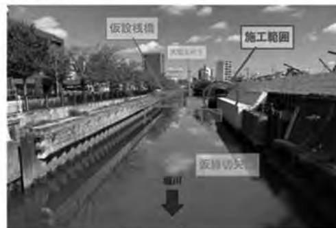
現場写真①
