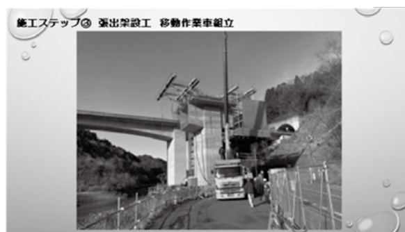
張出架設工 移動作業車組立
