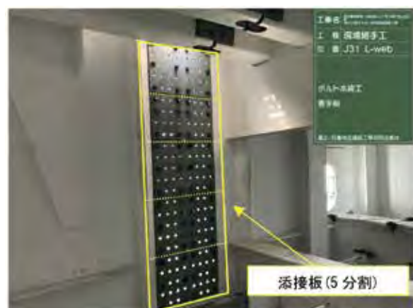
写真-10 ウェブ添接板（架設時）
