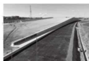
建設用 3D プリンターによる 重力式擁壁施工範囲 (延長 5m)
