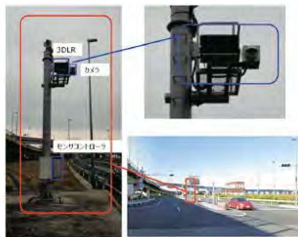
写真-1 三次元レーザレーダ設置状況
