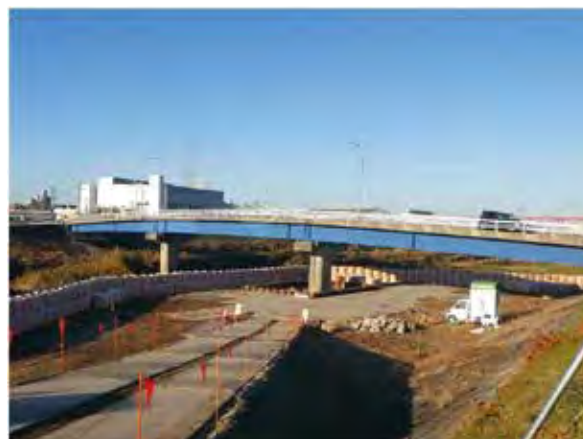
< 作業ヤード全景 >
