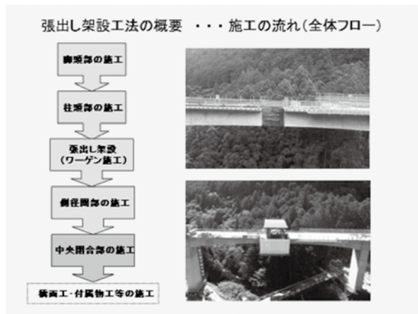
中央閉合部の施工
