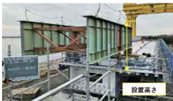
写真-3 セッティングビーム組立完了
