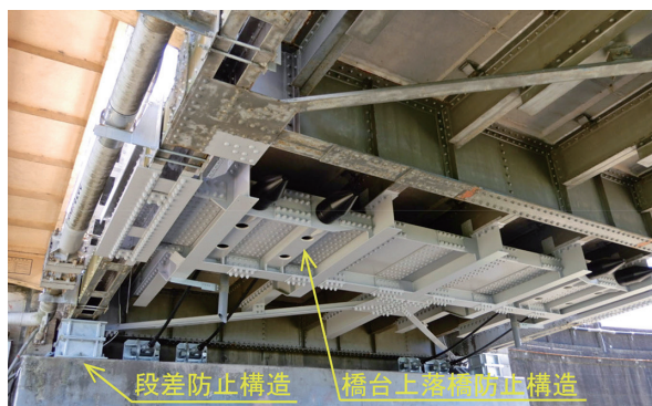
写真-2 橋台上落橋防止構造、段差防止構造
