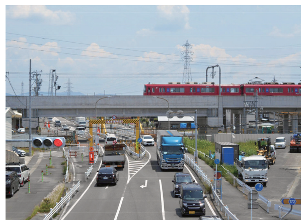
写真-6 上下線高架切り替え後の国道155号BP
