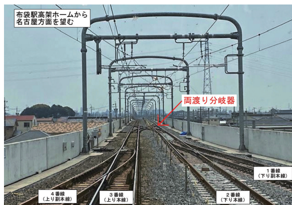
写真-3 布袋駅名古屋方に設置した両渡り分岐器
