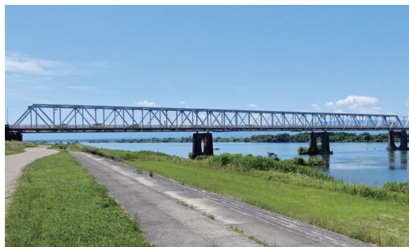
写真-1 架設完了後
