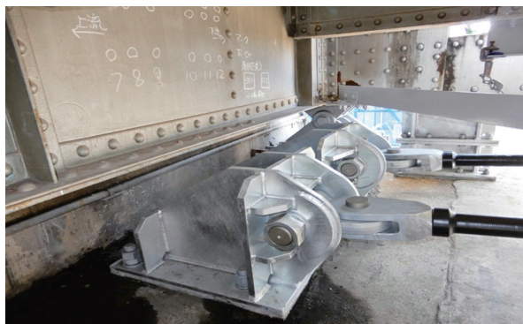
写真-7 橋台上落橋防止構造
