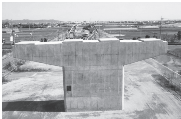
藤城建設(株) (23号蒲郡BP 為当高架橋下部工事) 伊與田淳児
