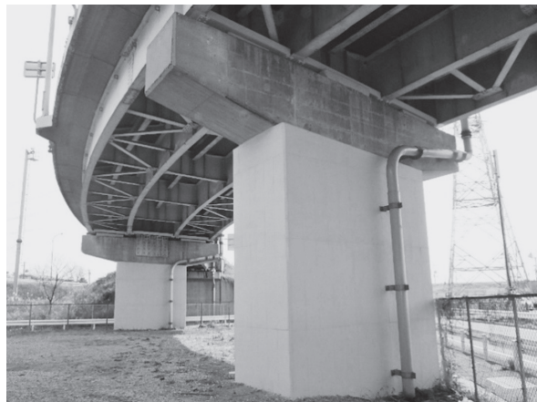
愛知県土木施工管理技士会会長賞 (株)加藤建設 (平成 29 年度第三第四出張所管内橋梁補強補修工事) 安井茂人
