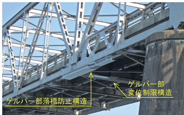
写真-3 ゲルバー部落橋防止構造、 変位制限構造
