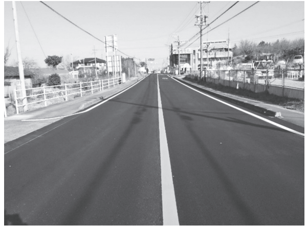
大有建設株式会社 (舗装道修繕工事 (3-2) 一般国道 366 号) 岩瀬洋平
