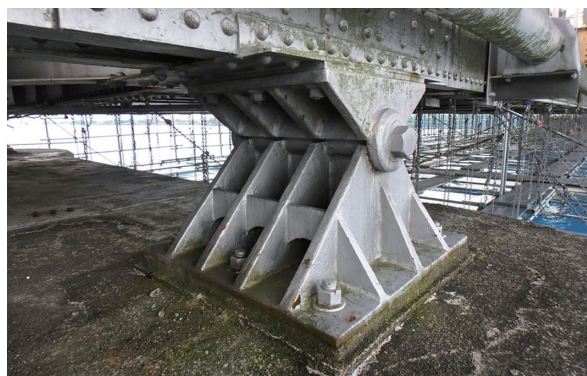
写真-9 支承金属溶射施工前
