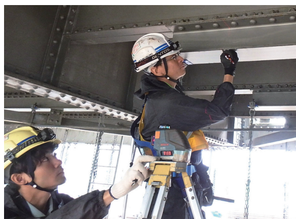
写真-4 レーザー水準器による野書き
