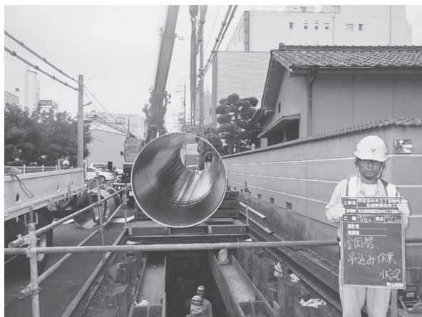
山田組(株) (西区花の木三丁目地内名城幹線改良工事・上下水道) 富田圭一
