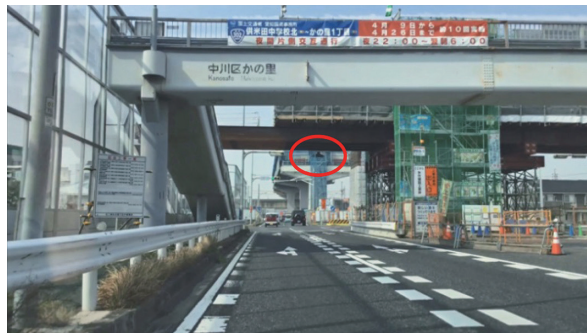
図2 特殊支保工施工後の同アングル
