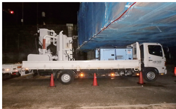
写真-8 橋台部金属溶射時状況
