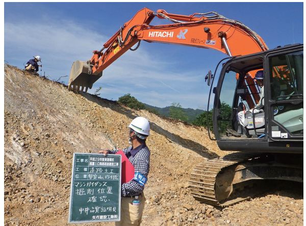
図4 ICTを活用した切土法面整形
