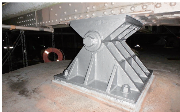
写真-10 支承金属溶射施工後
