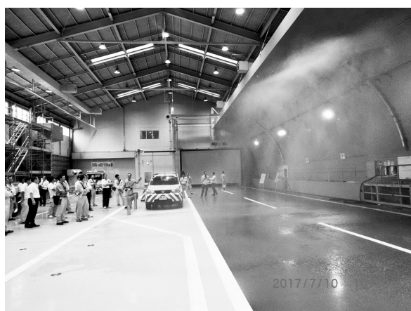
(トンネル内水噴霧設備)
