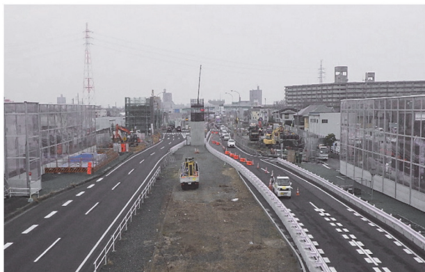
写真－1 着手前写真
