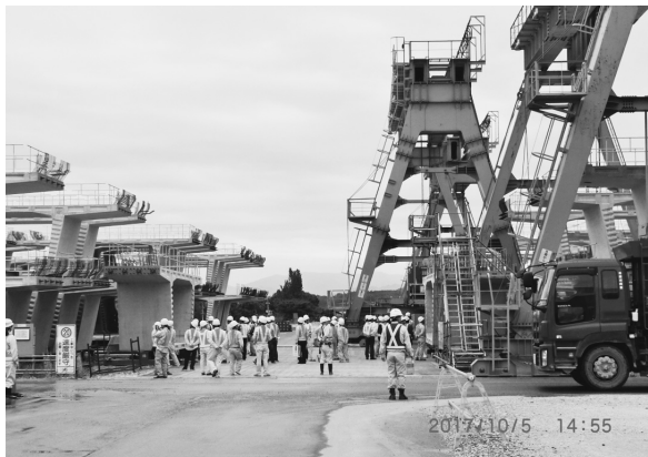
(鈴鹿高架橋セグメント仮置き場)
