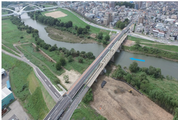
平成 28 年 9 月 30 日 I 期線供用 (上流側は撤去前の旧橋)
