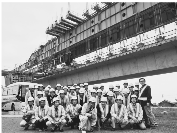
(鈴鹿高架橋桁架設現場)
