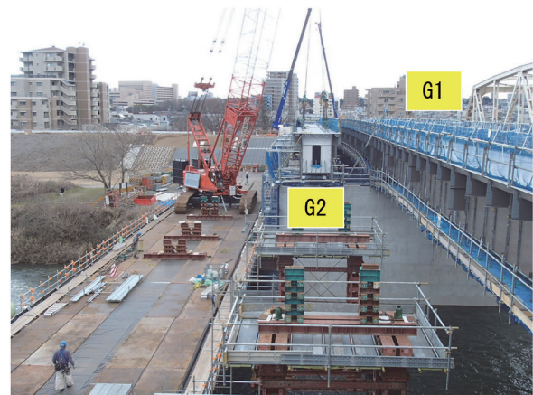
写真-4 G2桁架設
