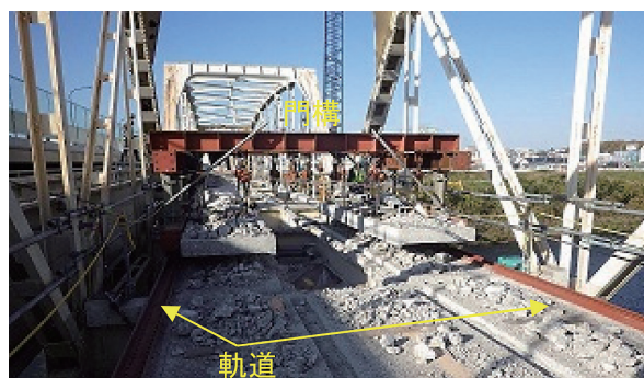
写真-7 門構によるRC床版ブロックの撤去
