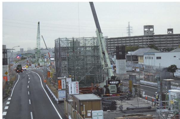
写真－2 H29.10月中旬進捗状況
