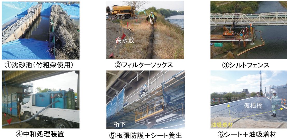
写真－8 水質汚濁防止対策
