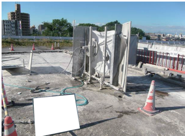
写真2 ワイヤーソー切断状況
