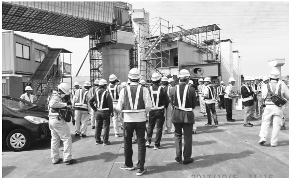
(飛島JCT建設現場)
