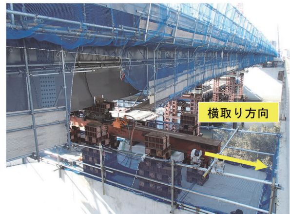
写真-3 G1桁横取り
