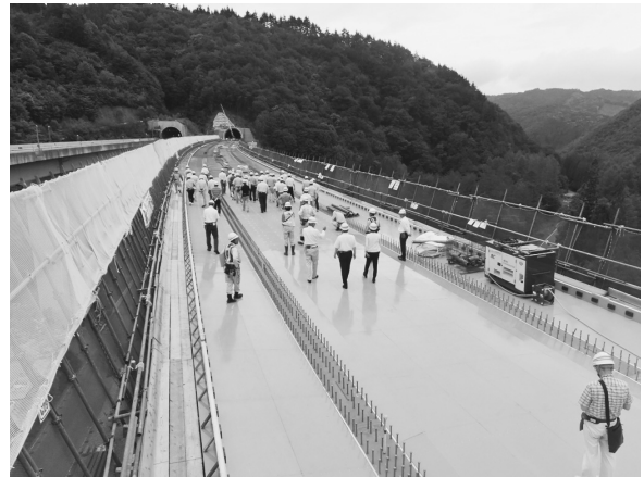
(三尾河橋建設現場)
