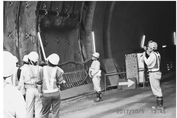
(四日市西トンネル建設現場)
