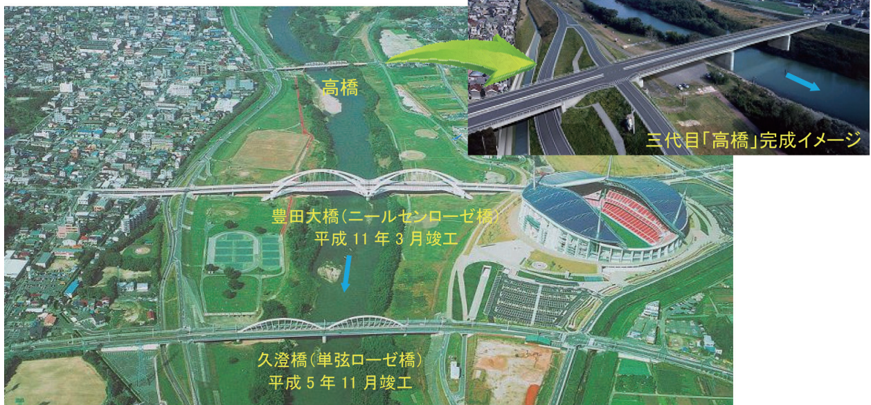
写真-5 周辺の橋梁
