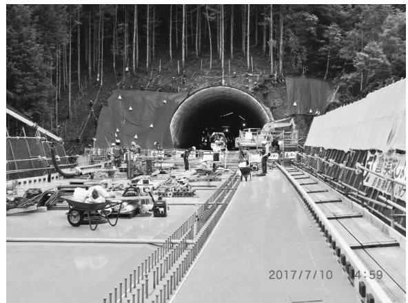
(三尾河橋上部工施工風景)
