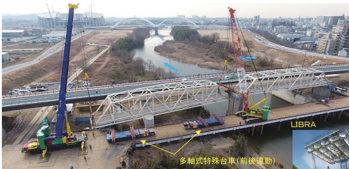
写真-6 トラス橋の一括撤去
