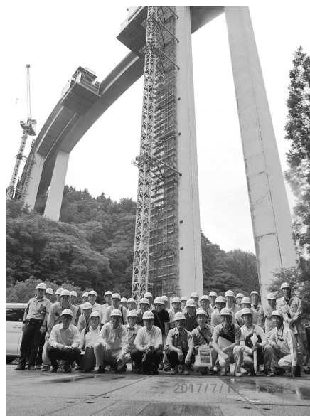
(鷲見橋建設現場)
