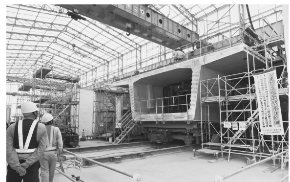
(鈴鹿高架橋セグメント製作工程)
