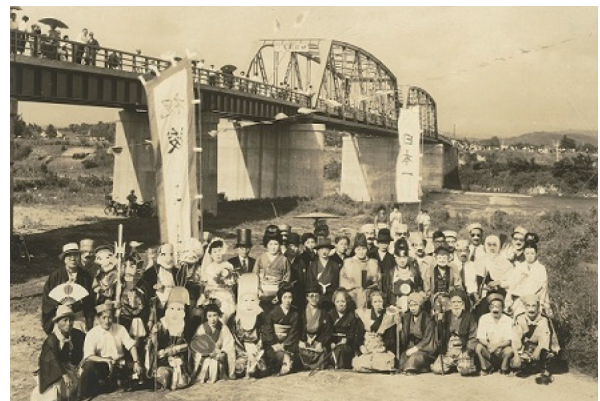
写真-4 二代目「高橋」の竣工式
