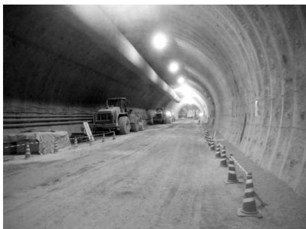
写真-1 LED照明を使用したトンネル坑内
