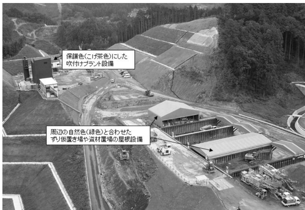
写真-3 保護色のトンネル仮設備
