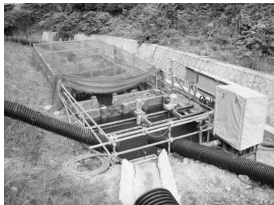
写真-7 明かり工場の汚濁水処理設備
