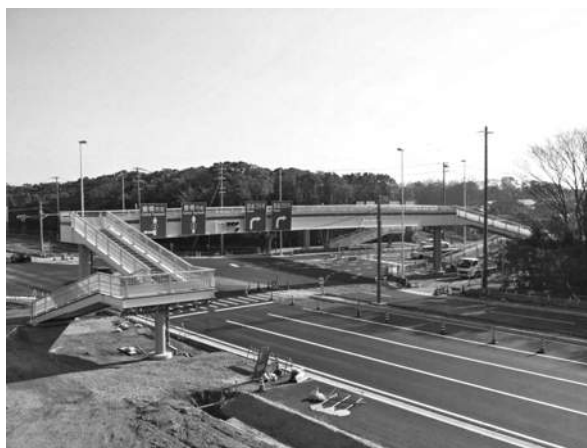
写真-4 架設完了
