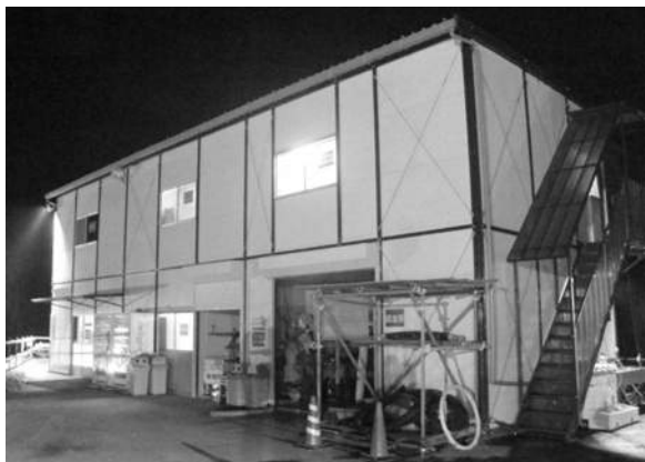
写真-5 防虫フィルムを設置した現場詰所
