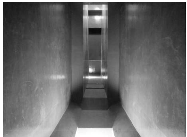
図-14 地下3階 沈砂地付近全景※防食工完了後（壁厚W=3.25m）3.25m
