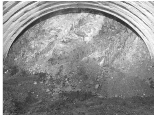
写真7 切羽鏡の崩落
