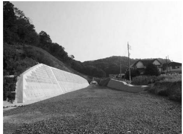
写真3 牛川工区(切土区間)
