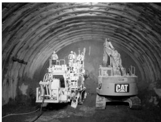
写真5 自由断面掘削機と大型ブレイカ
