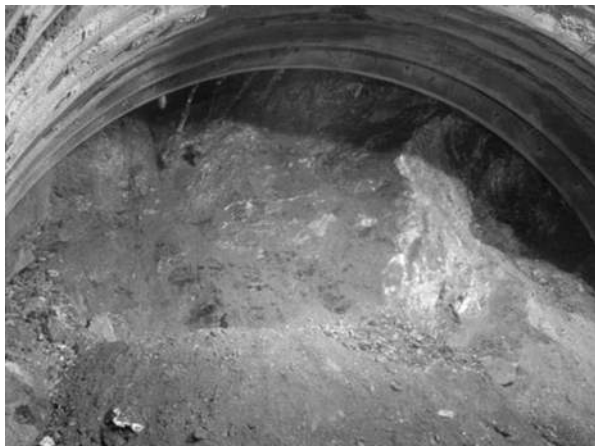
写真6 切羽天端の先抜け
