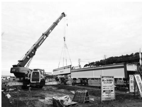
写真-1 通路桁地組立状況
