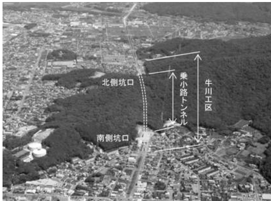
写真4 乗小路トンネル全景
