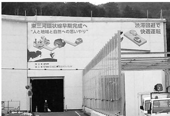
写真10 坑口防音ハウス
