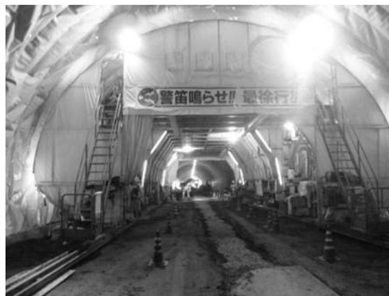
写真9 トンネル内のセントル
