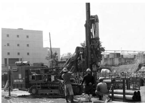
図-8 ロータリーパーカッション掘削機
