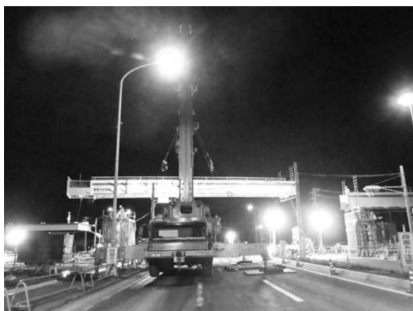
写真-2 夜間架設状況①
