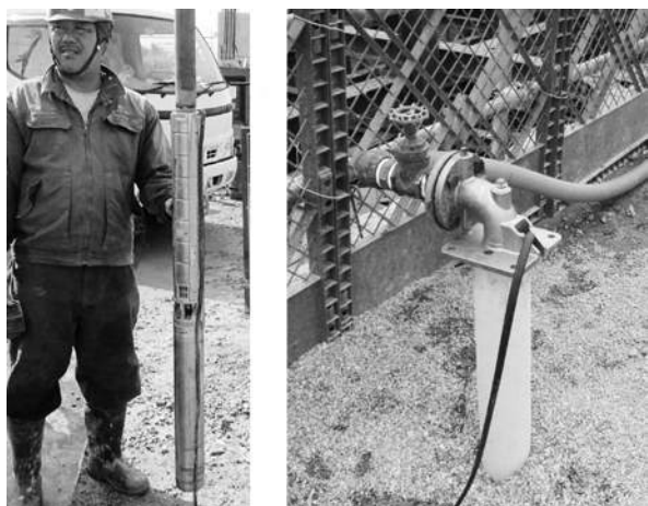
図-9 深井戸用水中ポンプ先端と減圧井戸 他
