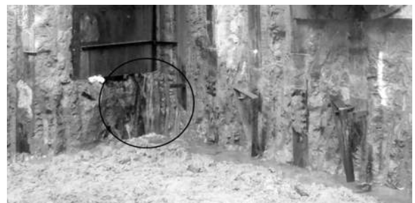
図-7 立坑内 地下21m付近 コーナー部漏水状況
