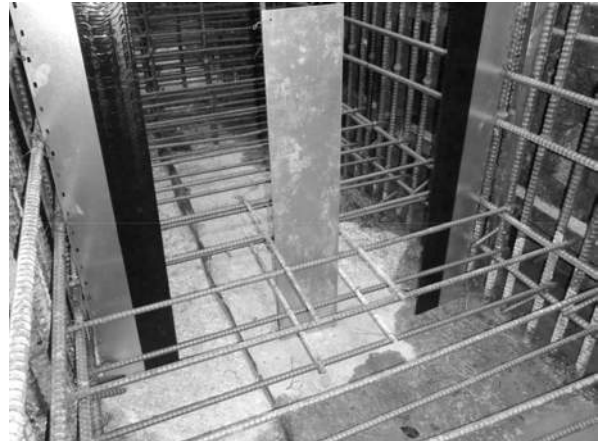
図-13 誘発目地設置状況（壁厚1.8m）
