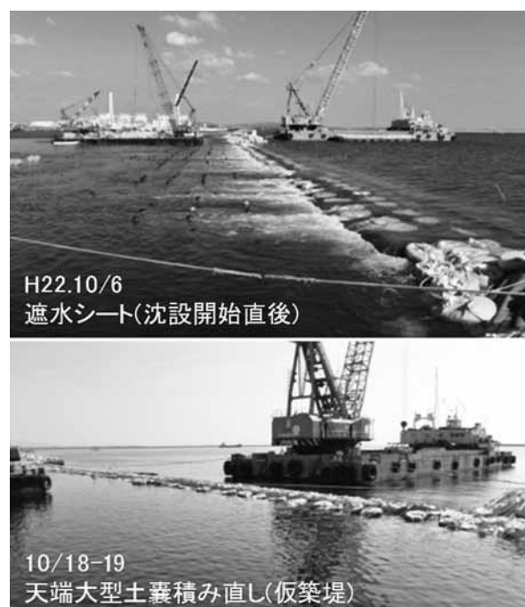
図-13. 開口部最終締切の施工状況
