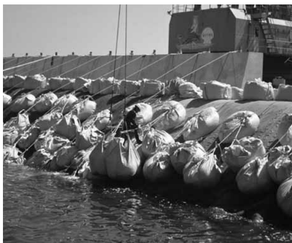
図-8. 大型土嚢の法面全面設置
