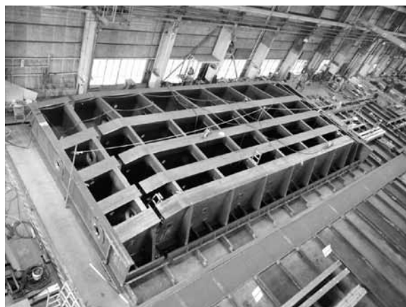
写真－14. 水門ゲート仮組立状況
