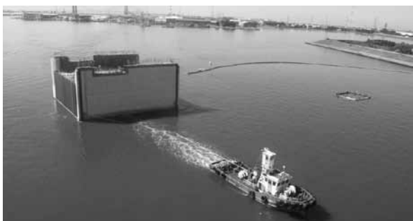
写真－8. 名古屋港内曳航状況
