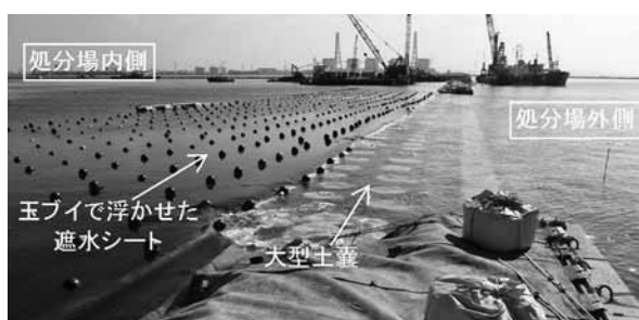
図-11. 遮水シート天端固定状況(下部堤体)
