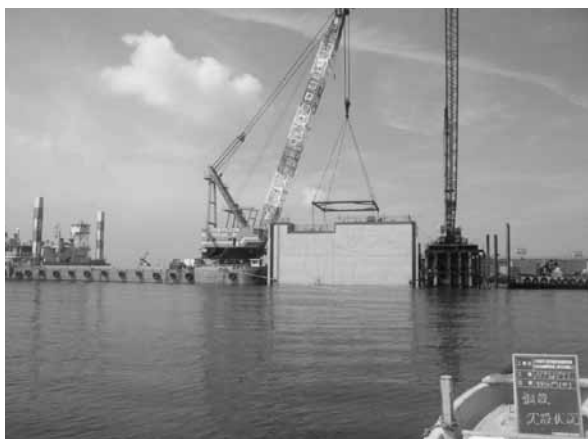
写真－10. 鋼殻沈設状況
