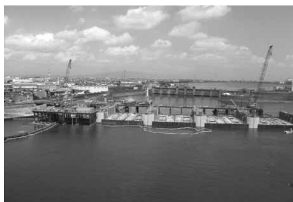
写真－11. 鋼殻沈設完了（全8函）
