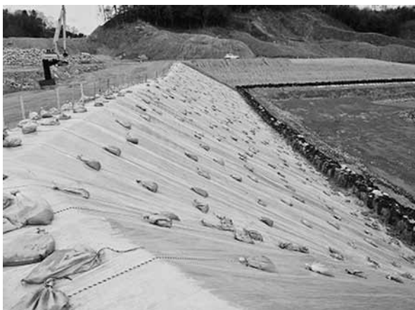
写真－5. 農ビシートによる養生状況
