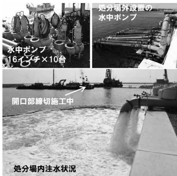
図-9. 大型水中ポンプによる注入
