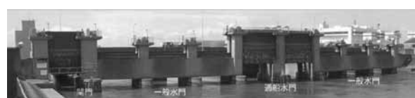
写真四 現水閘門 (右奥は排水機場)
