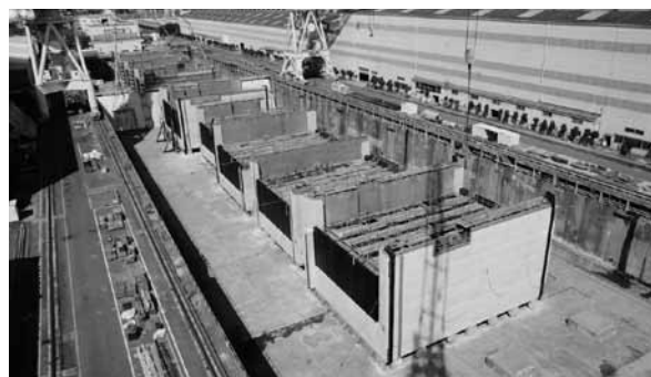
写真-6. 鋼殻製作完了
