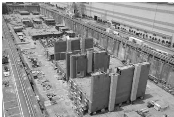
写真-5. 鋼殻組立て状況
