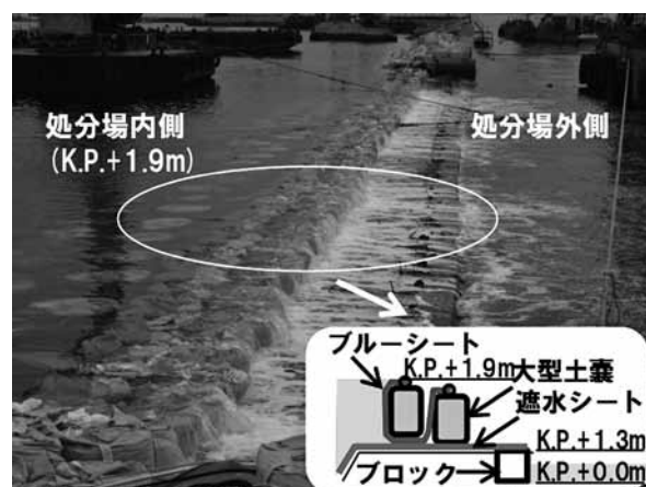
図-12. ブルーシート併用の大型土嚢仮築堤
