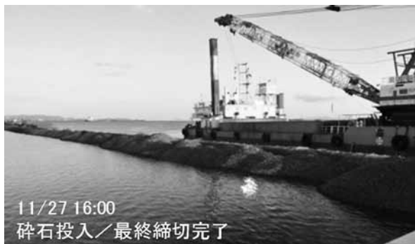
図－13. 開口部最終締切の施工状況 (つづき)
