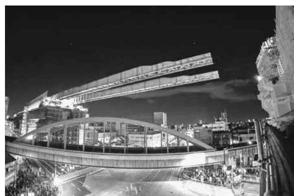
写真-2. 送出し架設状況
