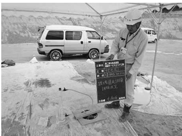
写真－4. 現場透水試験状況
