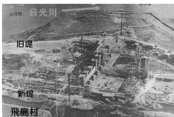
写真二 現水閘門施工状況 (昭和36年頃)
