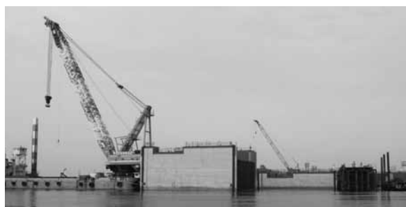
写真－9. 鋼殻誘導状況
