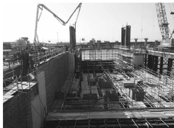
写真－12. 鋼殻内コンクリート打設状況
