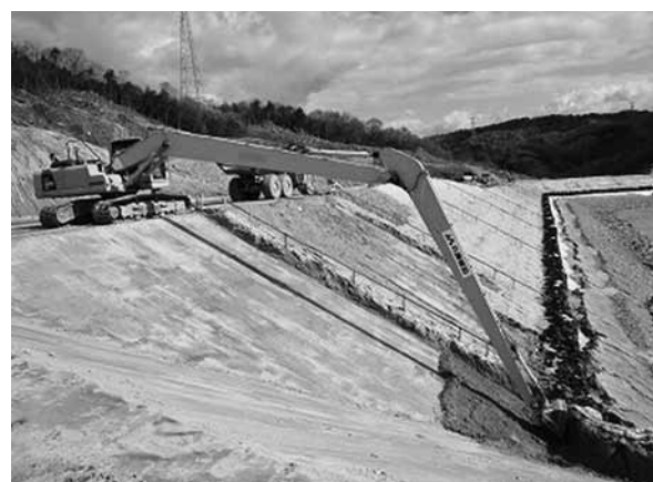
写真-3. 法面部の切土整形状況
